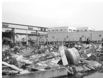
被災した石巻市の水産加工施設
